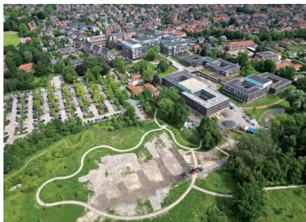
Der Rundweg auf der naturnahen Fläche ist wieder vollständig begehbar.
