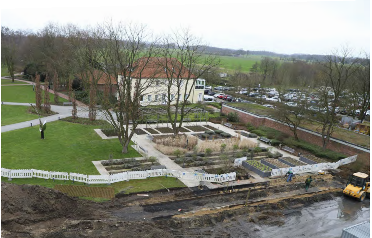
Blick von oben: Nach der Demontage des Bauzauns ist das Baufeld frei, um den Rosengarten mit einem Wasserspiel zu ergänzen. Im Februar wurde das 24 Meter lange Fundament vorbereitet für die zwölf Betonelemente, jedes Teil drei Tonnen schwer.
