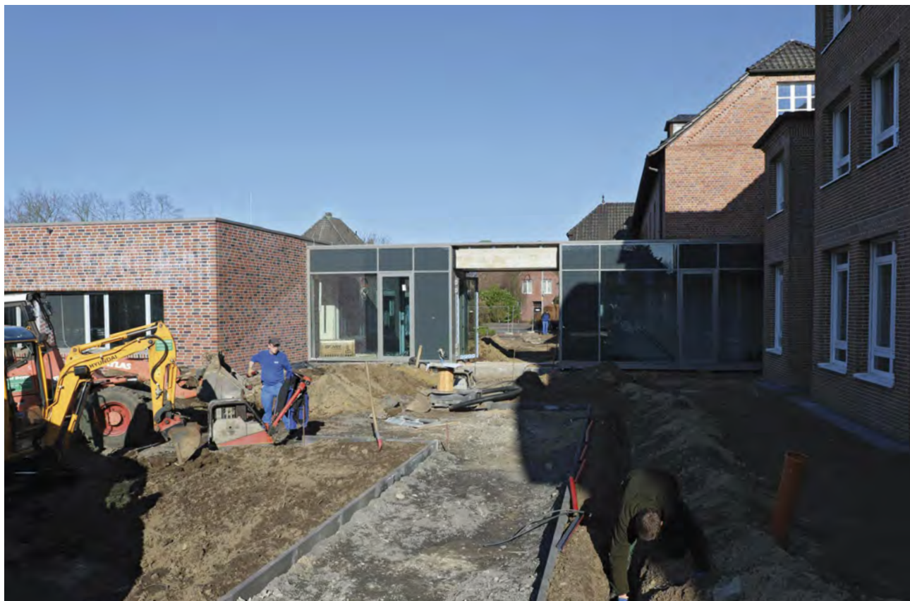
Mit Vollendung der Tagespflege St. Elisabeth wird auch der rote Fußweg zum Westtor wieder hergerichtet. Er führt künftig durch den Verbindungsgang zwischen St. Elisabeth-Stift und Tagespflege und sichert einen gefahrlosen Weg vom Parkplatz zum Krankenseingang am Westtor.
