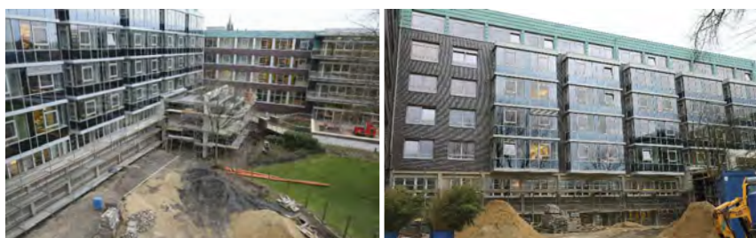
Bis der Südeingang im Sommer fertig wird, erfolgt der provisorische Zugang im Neubau.
