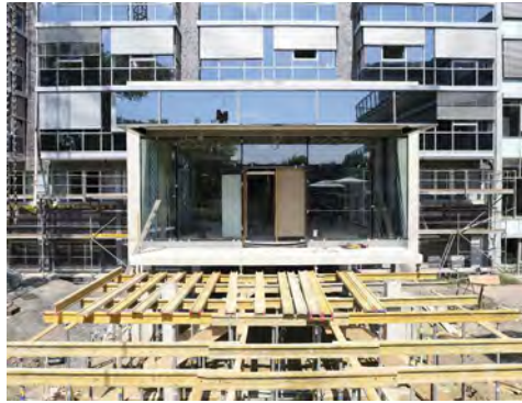
Das neue Entreee nimmt Gestalt an: Im Mai wurde die Betonbrücke gegossen, über die der Südeingang künftig erreichbar sein wird.
