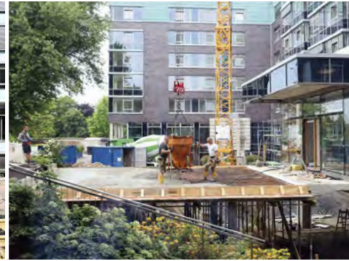
Das neue Entreee nimmt Gestalt an: Im Mai wurde die Betonbrücke gegossen, über die der Südeingang künftig erreichbar sein wird.
