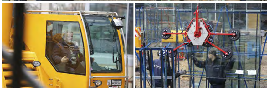
Spiderman: Viele Hände und eine große Tellersauganlage waren erforderlich, um das Sicherheitsglas für den Südeingang zu montieren. Die größten Scheiben wogen 300 Kilogramm.
