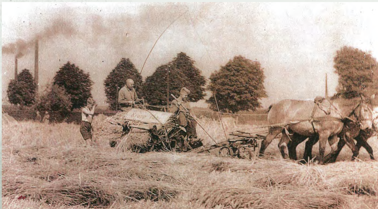
Drei Kaltblüter mussten den schweren Selbstbinder bei der Getreideernte ziehen. Ein großer Fortschritt war der spätere Einbau eines Sachs-Motors für das Bindewerk. Erst nach dem Zweiten Weltkrieg ersetzte der erste Trecker auf dem Limbrockschen Hof die Kraft der Pferde.
