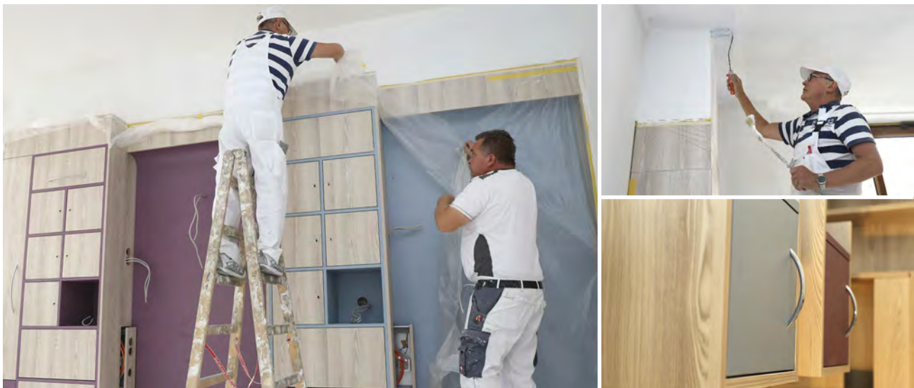
Unter der Malerfolie ist schon erkennbar, in welchen Farbtönen sich die Patientenzimmer der Station A 2 künftig präsentieren werden. Im Oktober beginnt der zweite Bauabschnitt, in dem bis Anfang 2019 die weiteren Zimmer und der Pflegestützpunkt erneuert werden.
