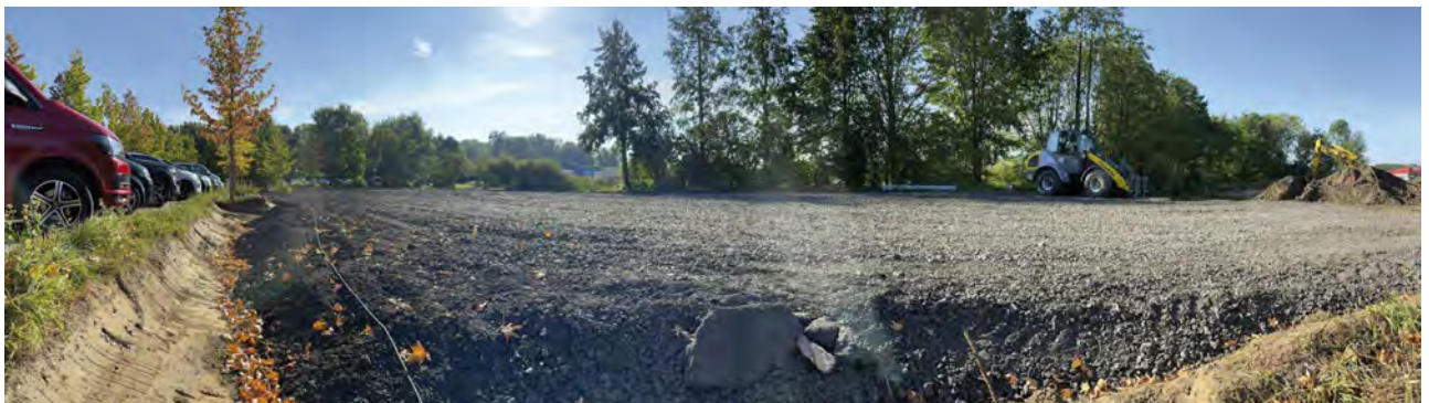
Die Planierarbeiten für zusätzliche Parkplätze begannen im September 2021.
