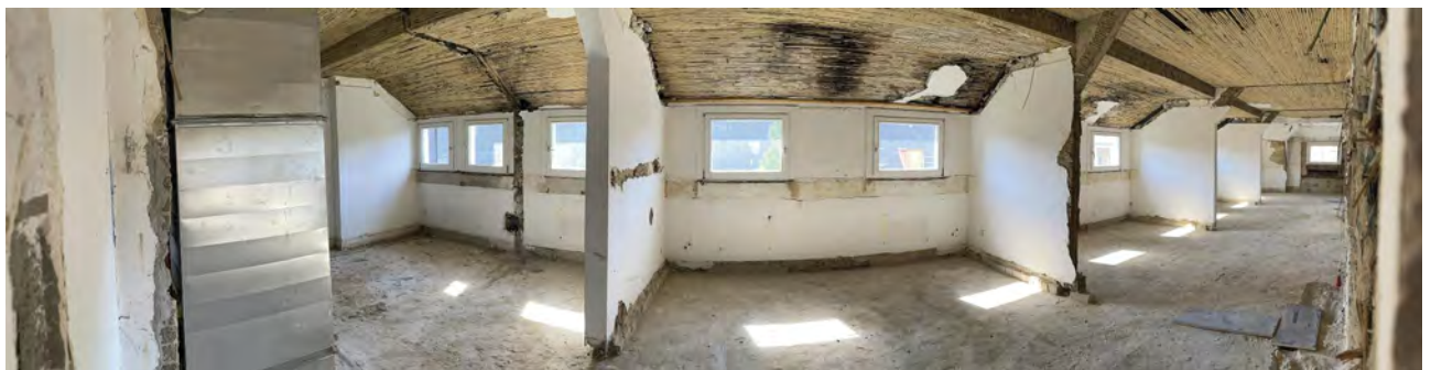
Nachdem das Klausurgebäude von innen komplett entkernt worden ist, wird aktuell die Außenhülle energetisch optimiert.
