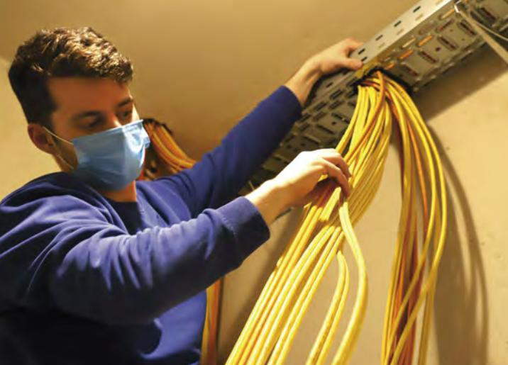
Armdicke Kabelbündel für WLAN und Handyempfang werden in allen Gebäudeteilen verlegt.
