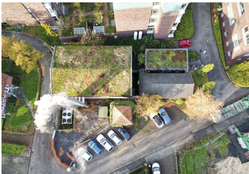
Dort, wo aktuell noch Autos parken, entsteht an der Pennigstiege die Erweiterung der Energiezentrale des St. Josef-Stifts. Sie wächst auf doppelte Größe.
