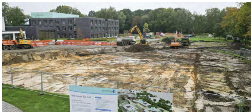
Mit schwerem Gerät musste viel Erdreich abgetragen werden, um das Baufeld für die Reha C anzugleichen.
