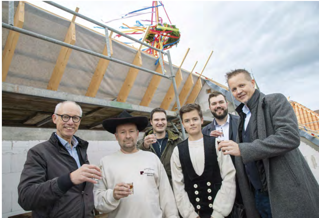
Unterm Richtkranz stießen Bauherren und Baufachleute auf den Meilenstein zur Errichtung der 36 Mitarbeiterapartments an. Die Fertigstellung ist Mitte 2024 geplant.
