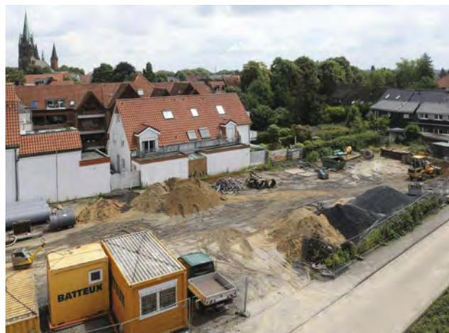
Die Vorbereitung des Baufeldes an der Pennigstiege läuft auf Hochtouren. Wie berichtet mussten sämtliche Versorgungsleitungen für Wasser, Strom, Telefon und Glasfaser nach Osten (vormals Gaststätte Elmenhorst) verlegt werden. Bis August entsteht zudem ein neuer Abwasserkanal. Anschließend wird die Baustraße eingerichtet, die nach Fertigstellung des Gebäudetrakts zur neuen Pennigstiege endausgebaut wird.
