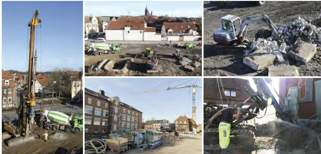
Mit großem Gerät wird der Baugrund vorbereitet: Spundwände wurden ins Erdreich gerammt (l.) und die Fundamente der vorhandenen Gebäude mit einer Betonspritze unterfangen (r. unten).
